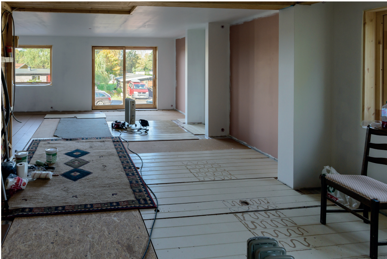
Venter på tørking. I dette rommet skal det legges parkett over vannbåren varme. Men siden det er brukt et sterkt luktende lim, er byggeprosjektet blitt utsatt mens limet tørker og gassen forsvinner.
